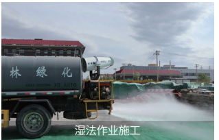
湿法作业施工
